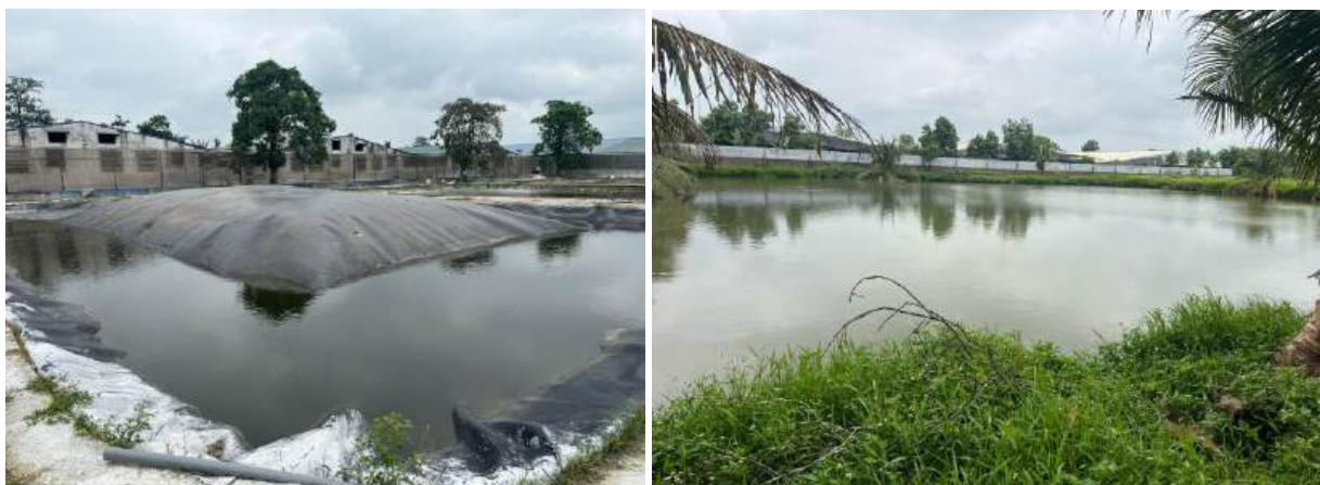
Hình 8. Hình ảnh hầm Biogas và ao lắng hiện trạng
